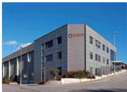
● Завод в Торелло (Испания)
